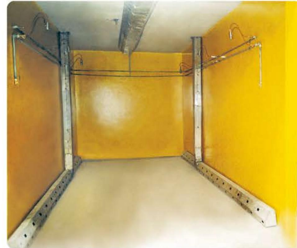
固化室内部管道布置
